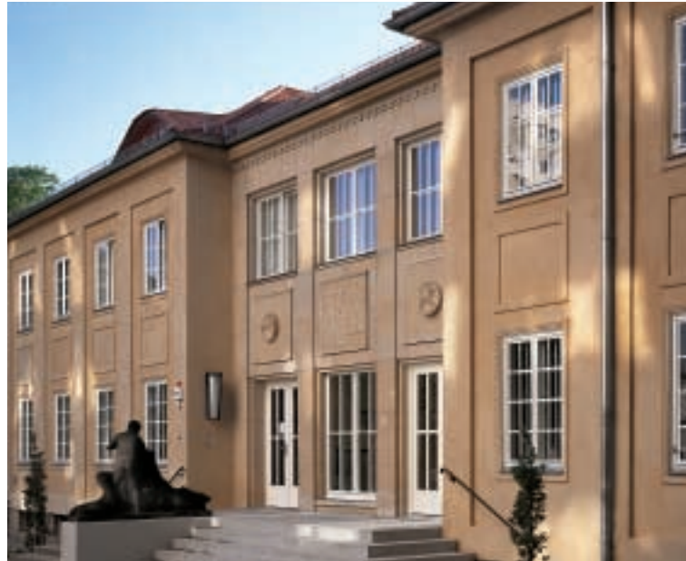
Altbausanierung, »Palais Nouveau®«, Am Kanal 66/67, Potsdam
